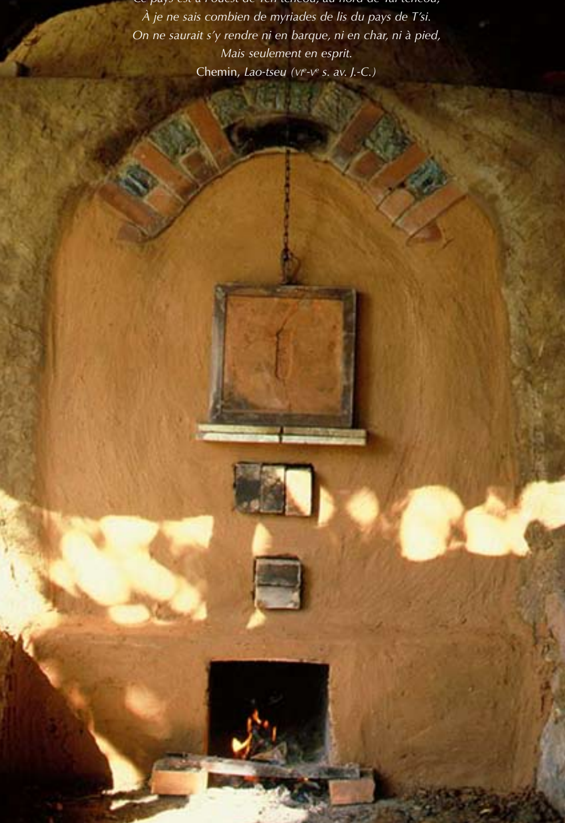
Petit feu. Allumage du four restauré pour une cuisson de 10 jours, à l'automne 1985. Une structure a été ajoutée à l'avant du four-tunnel existant, construit à partir de briques crues et de torchis. Photo : S. Kepp.
